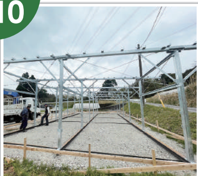
梁・ブレース・方杖設置
