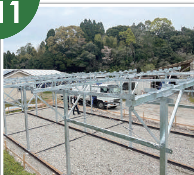
梁・ブレース取付(立上りコンクリート打設)
