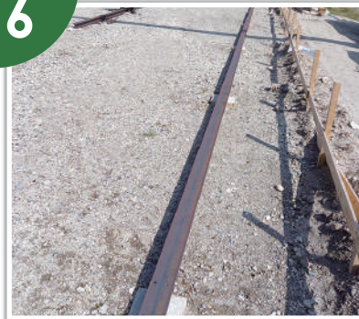
土台 H 鋼設置
