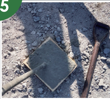
施捨コン打設（一部拡大）
