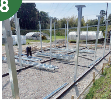
土台・柱(口100)ボルト固定
