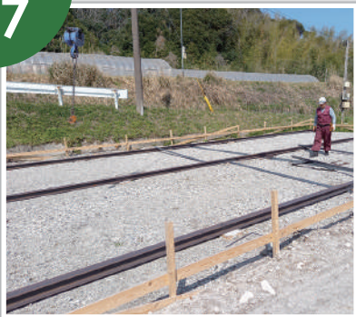
土台 H 鋼アングル固定
