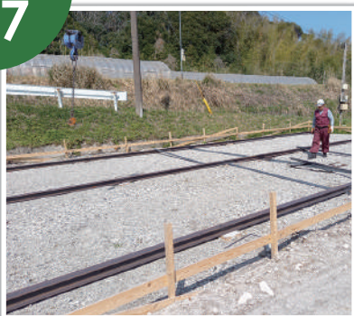
土台 H 鋼アングル固定
