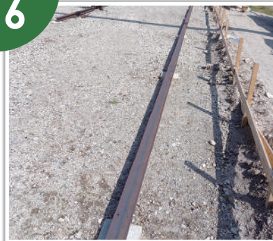
土台 H 鋼設置
