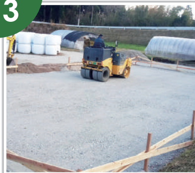
砕石敷き込み
