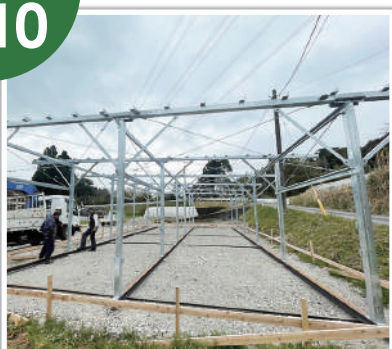
梁・ブレース・方杖設置
