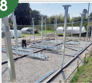
土台・柱(口100)ボルト固定
