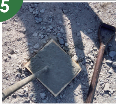
施捨コン打設（一部拡大）
